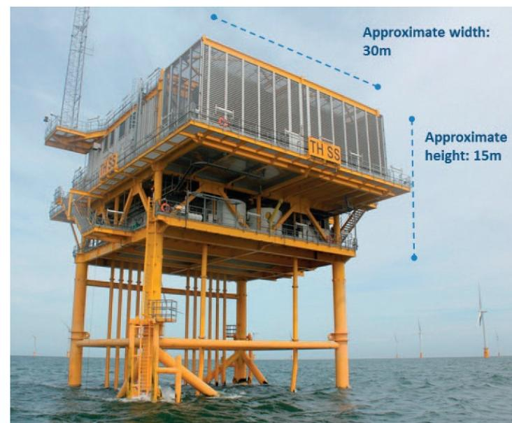
Sottostazione AC offshore (300MW) con struttura di fondazione tipo jacket - Thanet Offshore Wind Farm (Source: Royal HaskoningDHV)
